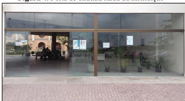
Figura 4. Porta de entrada/saída da instituição
