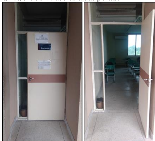
Figura 2. Sentido de abertura das portas.
