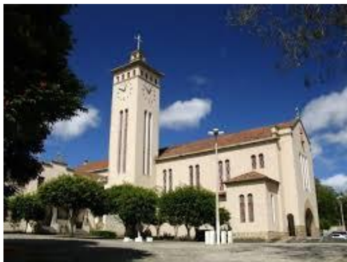
Figura 1 - Convento Ypuarana, Lagoa Seca (PB). Fonte: Fernandes (2016).
