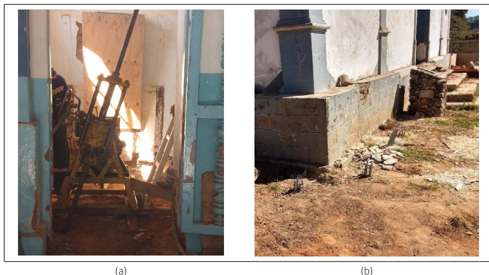
Figura 10 – (a) perfuratriz posicionada no interior da igreja e (b) estacas após a execução no exterior da igreja.
