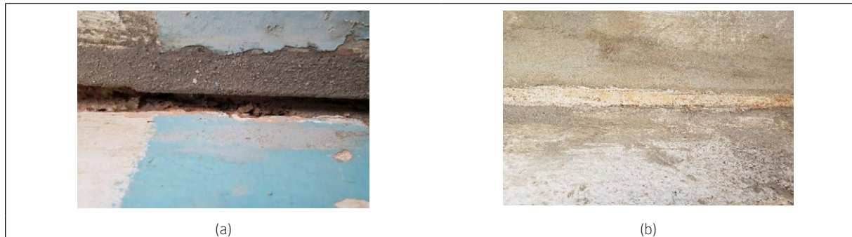
Figura 11 – Rachadura localizada entre as alvenarias da lateral esquerda e da torre: (a) antes do preenchimento (b) após o preenchimento com selante flexível.
