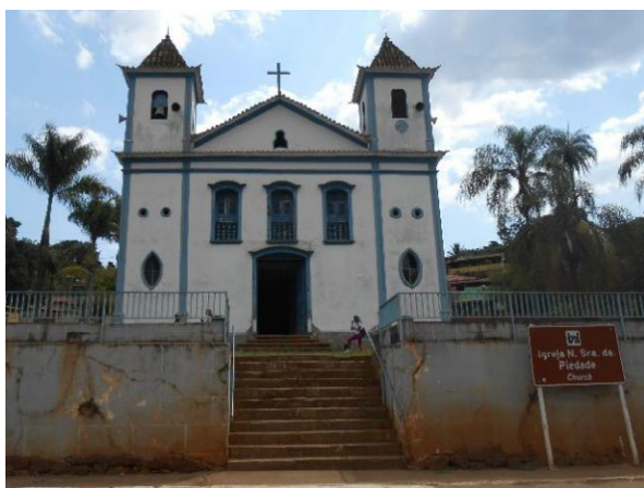
Figura 1 – Fachada frontal da Igreja Matriz de Nossa Senhora da Piedade, Brumadinho (MG).
