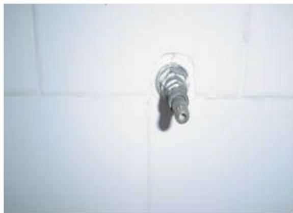
**Figura 16. Registro de pressão faltando volante**
