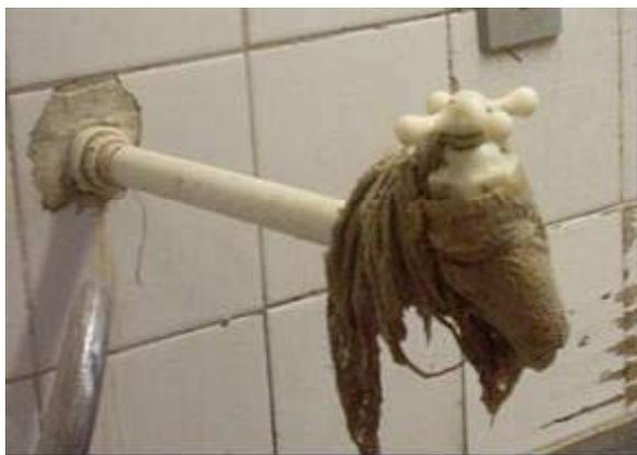
Figura 11. Torneira localizada no refeitório amarrada com faixa de tecido para evitar vazamento
