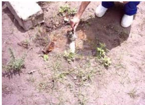
Figura 13. Registro de gaveta enterrado no campo de futebol apresentando vazamento
