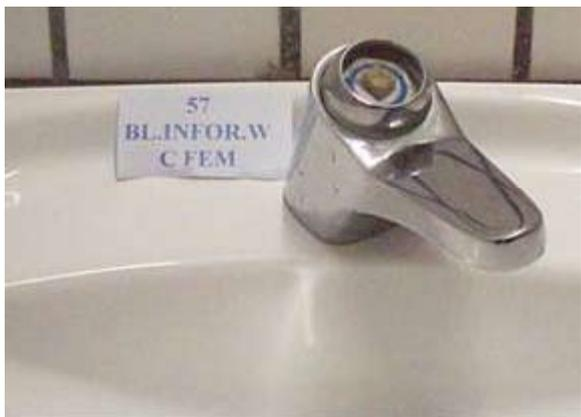
**Figura 14: Torneira sem peça de acionamento**
