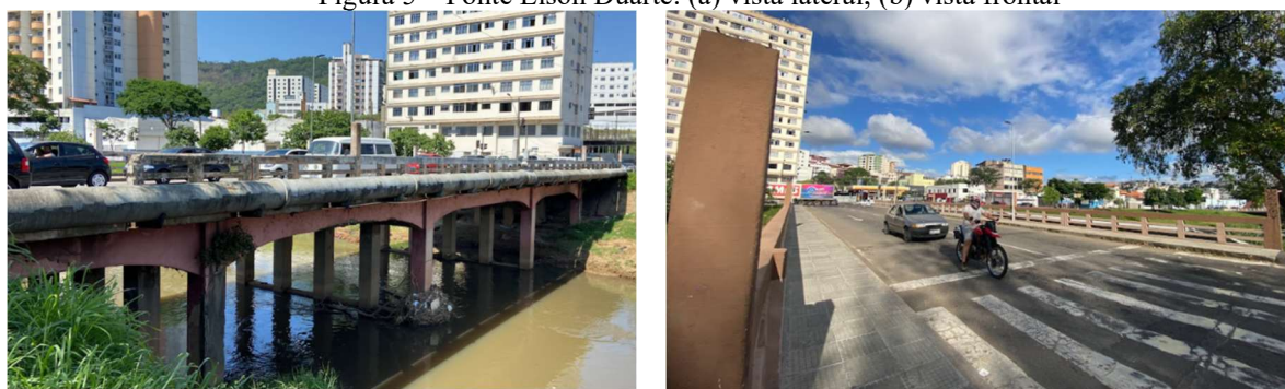
Figura 5 – Ponte Élson Duarte: (a) vista lateral; (b) vista frontal
