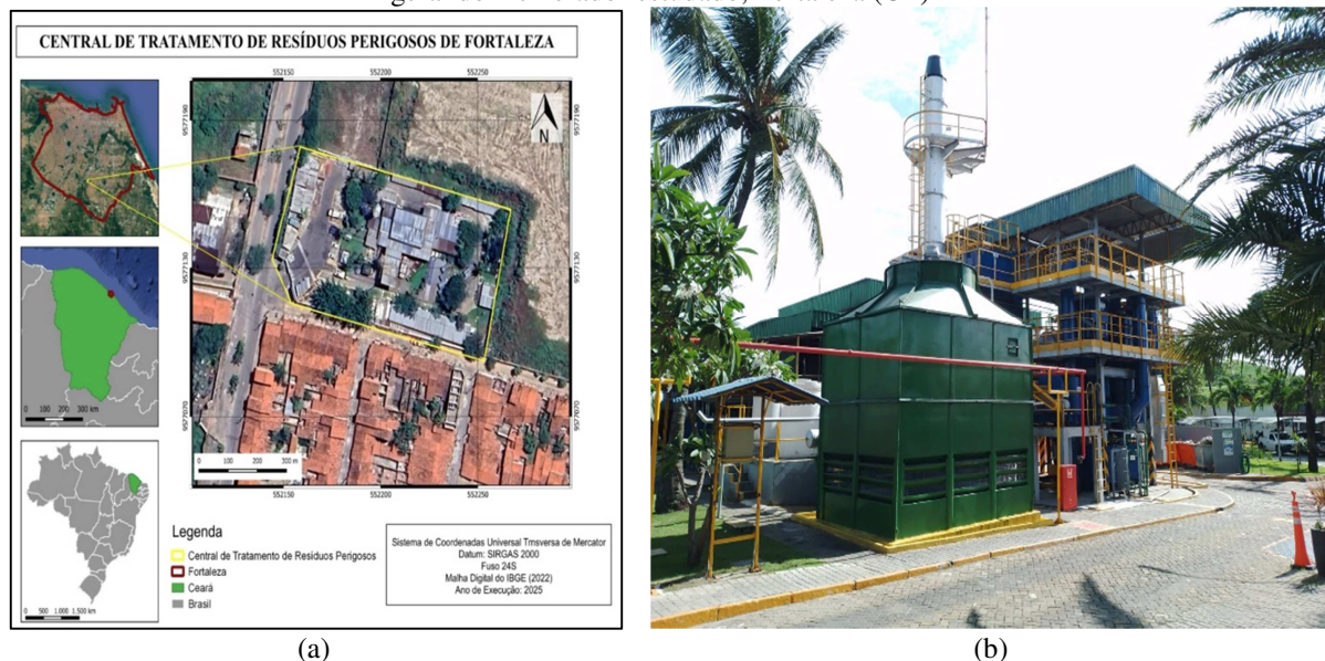
Figura 1 – (a) Localização do Centro de Tratamento de Resíduos Perigosos (CTRP), Fortaleza (CE). (b) Vista geral do incinerador estudado, Fortaleza (CE)
