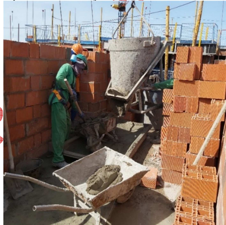
Figura 14 – Acessibilidade para a distribuição do concreto em carrinhos de mão no pavimento
