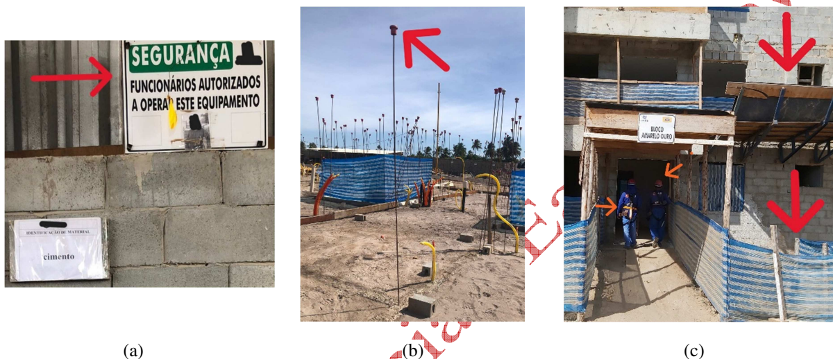
Figura 12 – Categoria facilitadora proteção da mão de obra. Exemplos de: (a) sinalização de segurança do trabalho; (b) elemento de proteção da armadura; (c) proteção coletiva de bandejas e de proteção no acesso ao prédio
