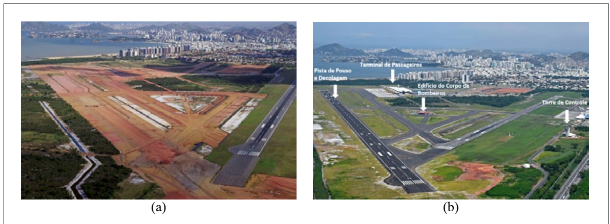
Figura 6 ▼ Aeroporto de Vitória, Espírito Santo, antes (a) e depois (b) da conclusão das obras. Fonte: arquivo dos autores
