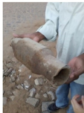
Figura 3. Registro fotográfico da canalização de cimento-amianto.
