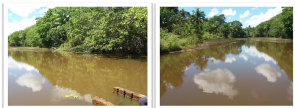
Figura 1 ▶ Represamento de água em Vila Maria Jape. Fonte: arquivo dos autores
