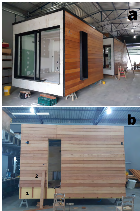
Figura 14 – (a) face revestida com chapas cimentícias e (b) camadas da face revestida com réguas de madeira sendo montadas na fábrica
