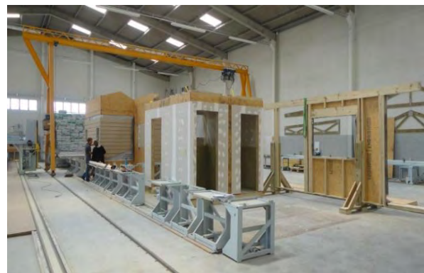
Figura 4 – Linha de fabricação modular na etapa de montagem dos módulos
