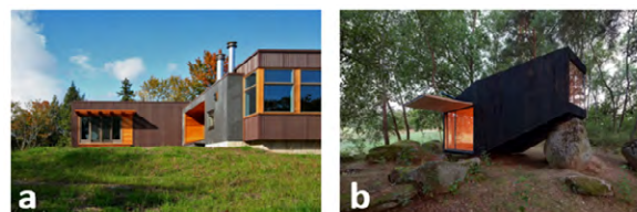
Figura 11 – (a) Composição de vedações externas de chapas metálicas e cimentícias, (b) madeira carbonizada como vedação externa
