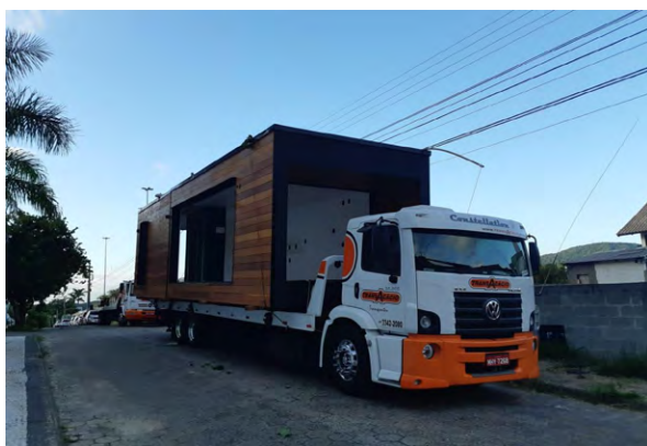
Figura 5 – Um módulo de madeira sendo transportados para um terreno na Lagoa da Conceição em Florianópolis (SC)
