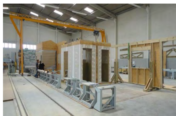
Figura 4 – Linha de fabricação modular na etapa de montagem dos módulos
