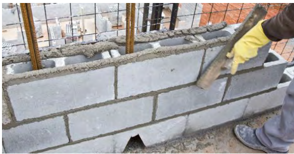
Figura 3 – Execução de parede de alvenaria estrutural com blocos de concreto
