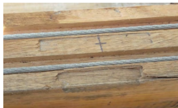
Figura 15 – Contato do apoio central na superfície inferior da viga para execução da contra-flecha
