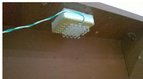
Figura 5 – Fixação da placa de LEDs.
