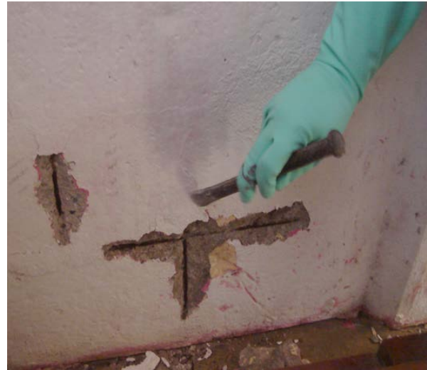
Figura 5 – Reparos nas placas de concreto.
