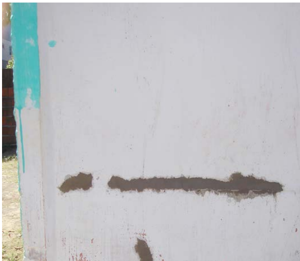
Figura 4 – Reparos nas juntas entre placas.
