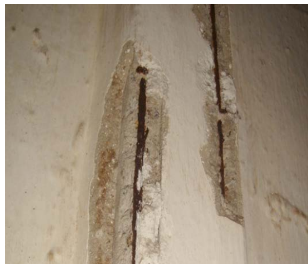
Figura 6 – Reparos nas fissuras nos pilares.
