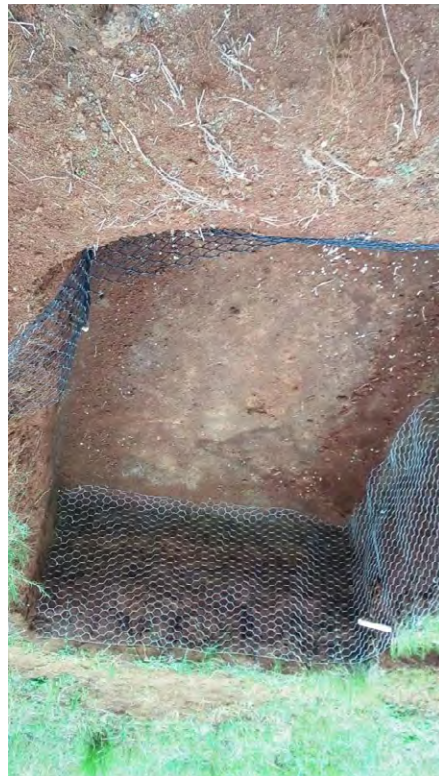
Figura 11 ▶ Preparação prévia da bacia de evapotranspiração. Fonte: arquivo dos autores
