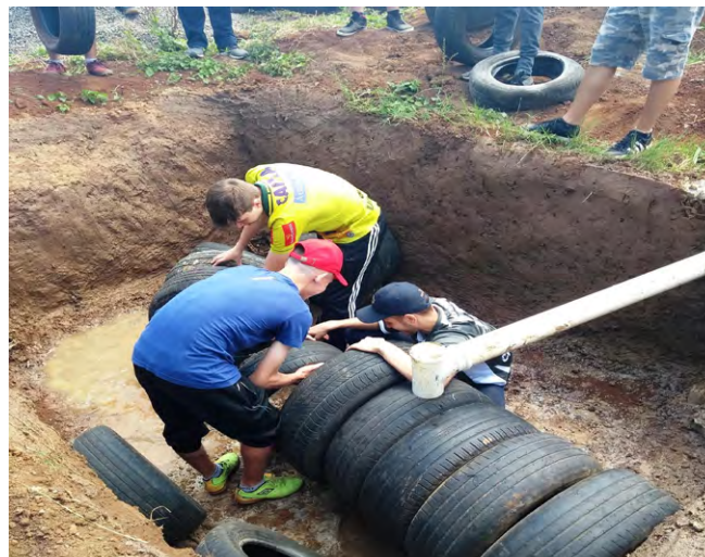
Figura 12 ▶ Montagem da bacia de evapotranspiração. Fonte: arquivo dos autores
