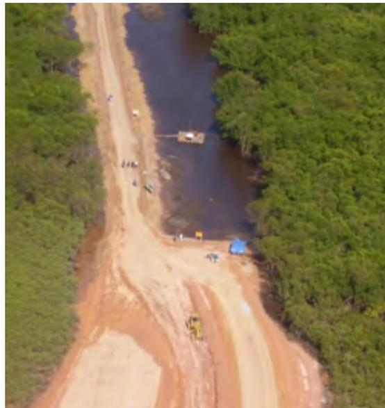
Foram coletadas 30 amostras indeformadas tipo pistão estacionário de paredes finas, com tubos aço-inox com diâmetros 4” e 4,5” (100 mm e 110 mm) e comprimento 1000 mm. Foi aberto um total de 88,0 m de furo, com ordem de aproveitamento útil do material amostrado de 70 cm a 85 cm de comprimento. Foram realizados ensaios de Vane Test e Piezocone nas estacas (E98, E102, E112, E120, E137 e E144). A Figura 3 apresenta o perfil geotécnico da área escolhida para esse estudo.
