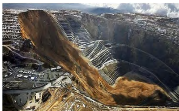
Figura 2 – Exemplo de ruptura ocorrida em talude da mina Bingham Canyon (10/04/13)
