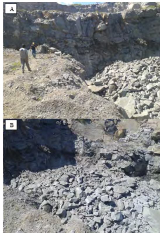
Figura 14 – A) Destaque à pilha formada: observar que os blocos de maior dimensão são provenientes de regiões de maior engaste acima do talude; B) Vista da pilha formada após a detonação
