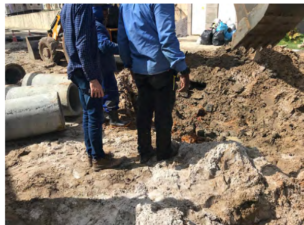
Figura 15 – Utilização de rádio comunicador na obra “C”
