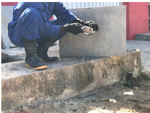
Figuras 6 – Abertura para passagem da tubulação executada in loco na obra “A”
