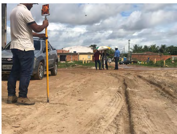
Figura 8 – Locação dos pontos topográficos na obra “A”
