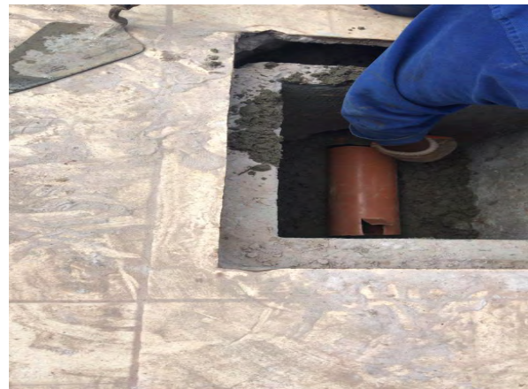
Figura 14 – Execução de canaletas nas caixas de inspeção na obra “C”
