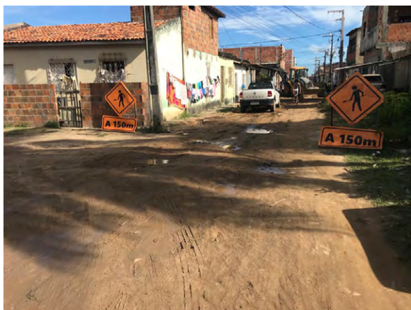
Figura 9 – Sinalização nas frentes de serviço na obra “B”
