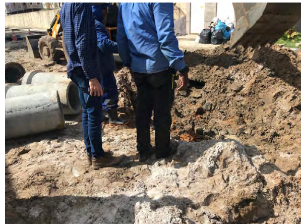
Figura 15 – Utilização de rádio comunicador na obra “C”
