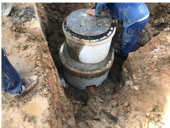
Figura 10 – Abertura para passagem da tubulação realizada in loco na obra “B”
