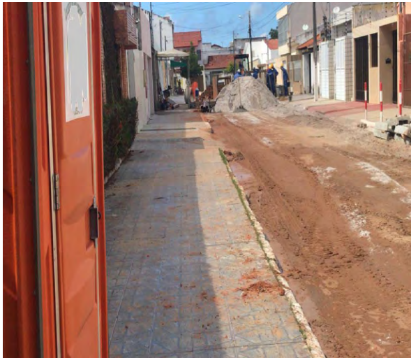
Figura 12 – Frente de serviço com ponto de apoio na obra “C”
