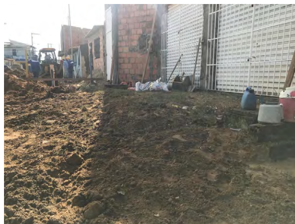
Figura 11 – Ponto de apoio para a frente de serviço na obra “B”
