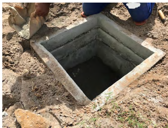
Figura 5 – Utilização de complementos na caixa de inspeção na obra "A"
