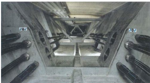
Figura 5 – Viaduto “Bois de Rosset”, Suíça
