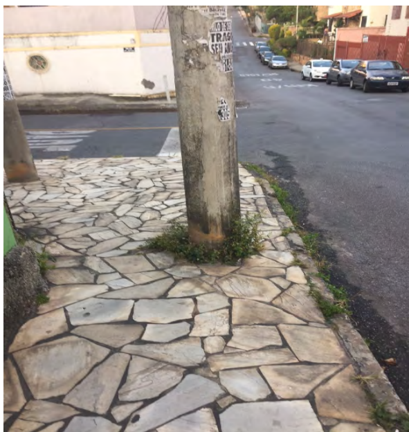
Figura 12 – Mobiliário urbano mal posicionado
