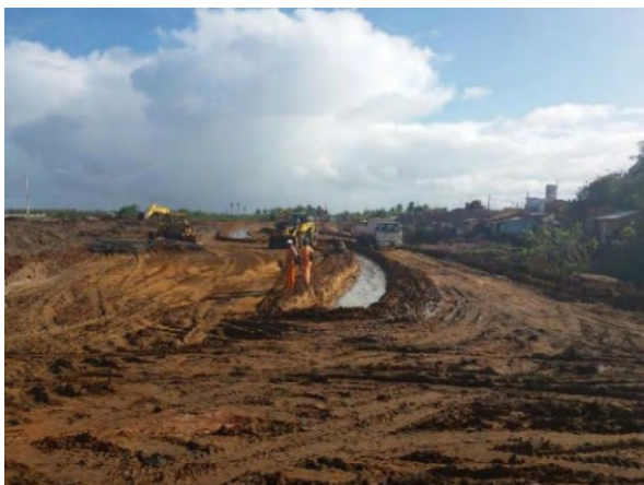
Figura 3 – Obra de dragagem do canal Santa Maria
