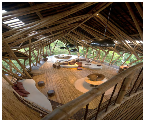
Figura 7 – Coberta com bambus suspensos
