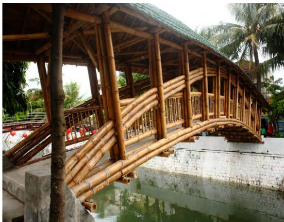
Figura 5 – Estrutura de bambu
