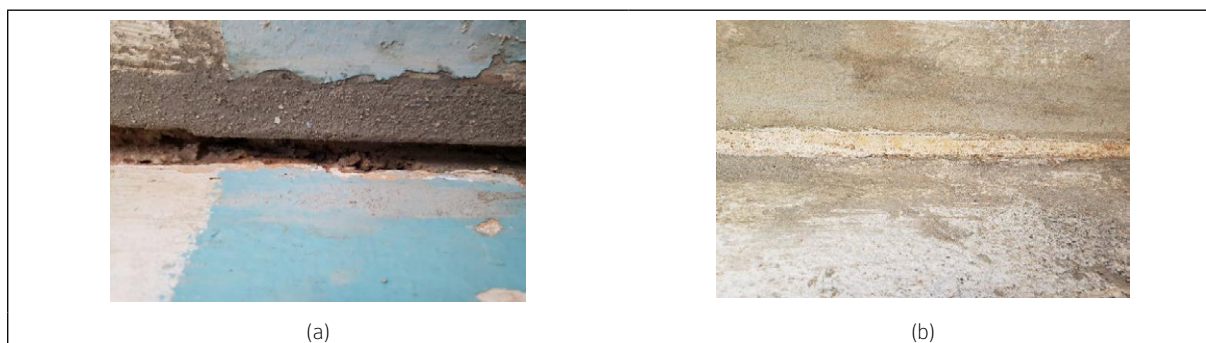
Figura 11 – Rachadura localizada entre as alvenarias da lateral esquerda e da torre: (a) antes do preenchimento (b) após o preenchimento com selante flexível.
