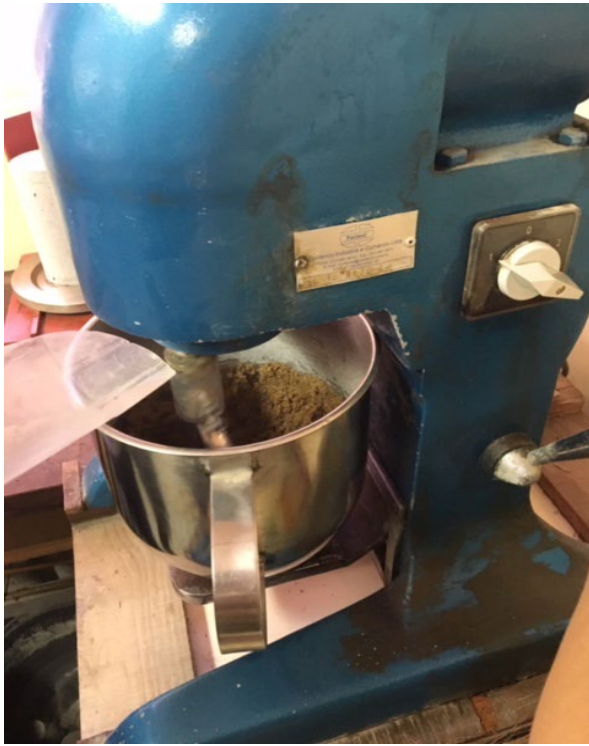
Figura 4 – Preparação da argamassa
