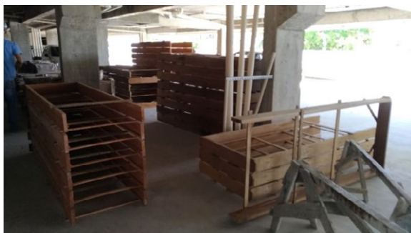
Figura 10 – Portas empilhadas próximo ao local de uso (obra da Construtora “E”)
