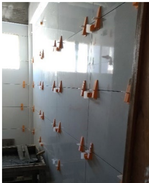
Figura 9 – Cunha niveladora de revestimento cerâmico (obra da Construtora “E”)
