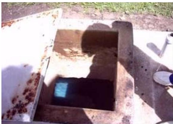
Figura 3. Cisterna sem vedação apropriada
