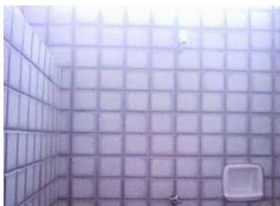
**Figura 17. Instalação de chuveiro sem crivo**
