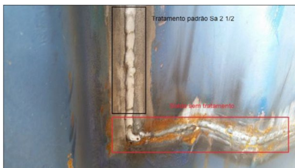
Figura 9 – Tratamento da solda
