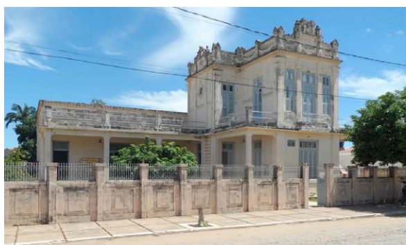
Figura 1 – Frente do Casarão de Zé Pereira (Acesso Principal)
