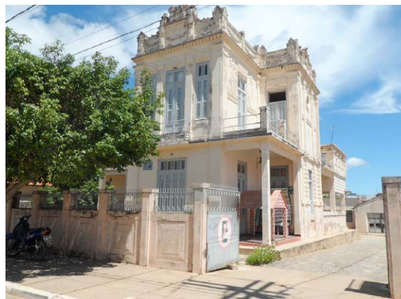
Figura 2 – Frente do Casarão de Zé Pereira (Acesso Garagem)
