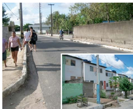
Figura 02 – Acesso ao conjunto habitacional. No detalhe, casas de alvenaria
