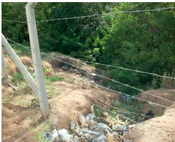
Figura 03 – Material de aterro argiloso e presença de resíduos sólidos domésticos lançados pelos moradores em volta do talude
