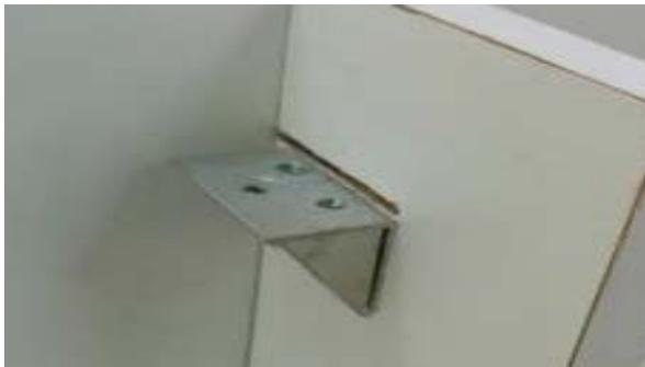
**Figura 4** – Detalhe dos parafusos de fixação.
