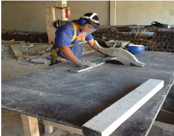
Figura 3 – Utilização da serra com a coifa levantada
