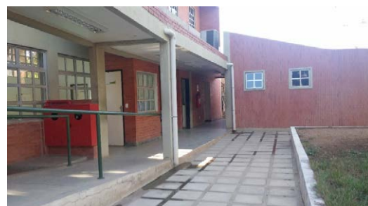
Figura 17 – Lançamento de águas pluviais diretamente sobre superfície impermeável (acesso ao refeitório)
