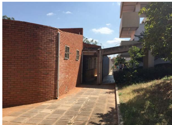
Figura 13 – Captação das águas pluviais em telhados com lançamentos dos volumes em áreas de circulação externa
