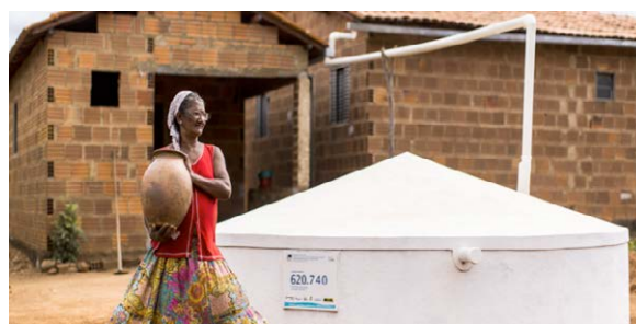
Figura 3 – Cisternas de placa e sistema de captação do telhado do P1MC
