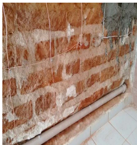
Figura 4 – Método implantado com dreno PVC
