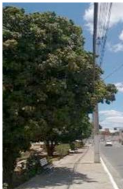
Figura 12 – Galhos de árvore ultrapassando o limite da fiação elétrica na Praça Onésio Uchoa
