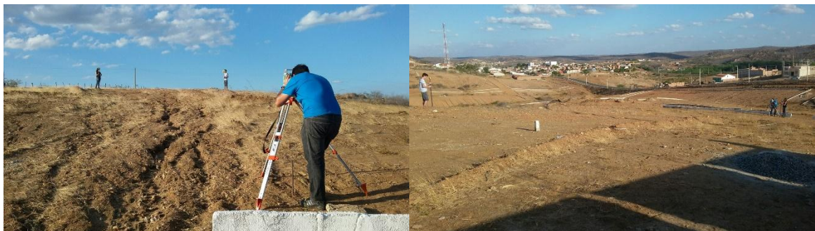
Imagens 01 e 02 – Levantamento topográfico realizado no lote a ser executada a edificação proposta. Fonte: acervo próprio.
