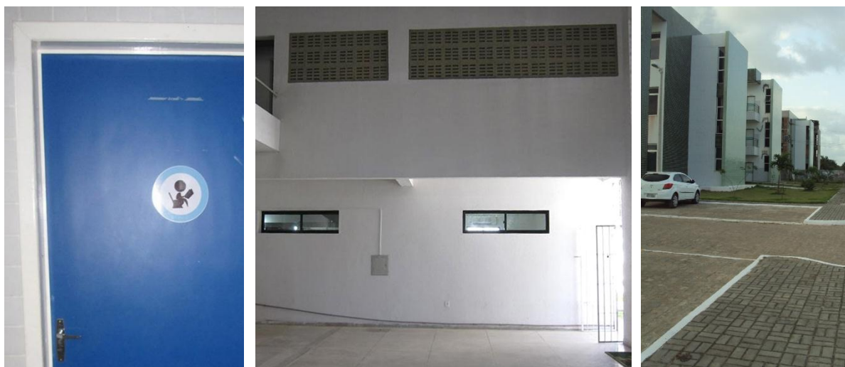
Figura 4 – Pictograma de difícil reconhecimento (à esquerda), Ponto de decisão sem placa direcional (ao centro). Blocos de aula sem placas indicativas (à direita). Fonte: autoria própria, 2015
