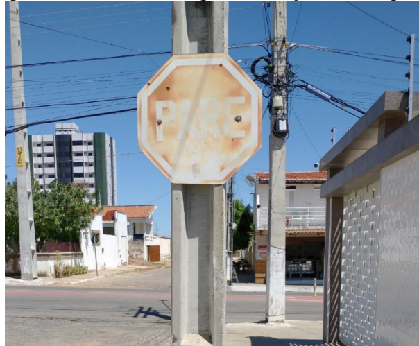
Figura 01 - Placa de Regulamentação R-1 ilegível.
