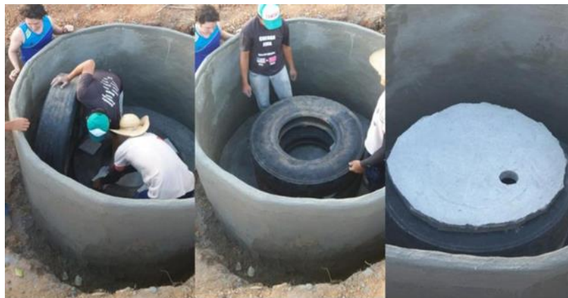
Figura 7 - Construção da câmara anaeróbica
