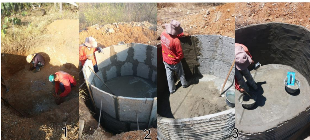
Figura 6 - Etapa de construção do TEvap
