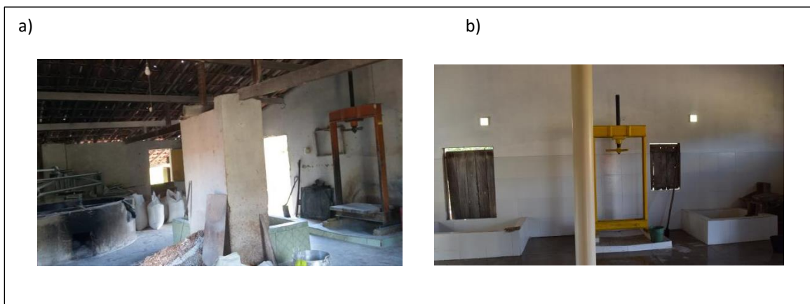
a) Casa de farinha antes da reforma b) Casas de farinha após a reforma (parcial)
