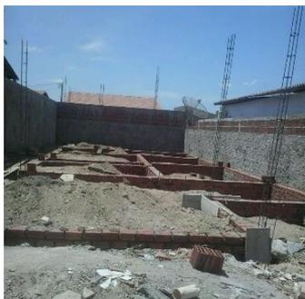
**Imagem 04 -** Construção de uma residência para idosos na fase de fundação.
