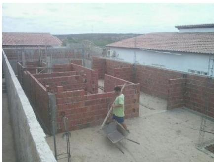
**Imagem 05 -** Construção de uma residência para idosos na fase de levantamento de alvenaria.
