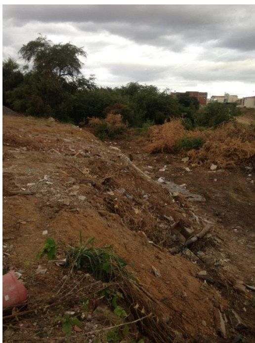
Figura 9 – Assoreamento de riacho associado a rejeitos construtivos Fonte: autoria própria
