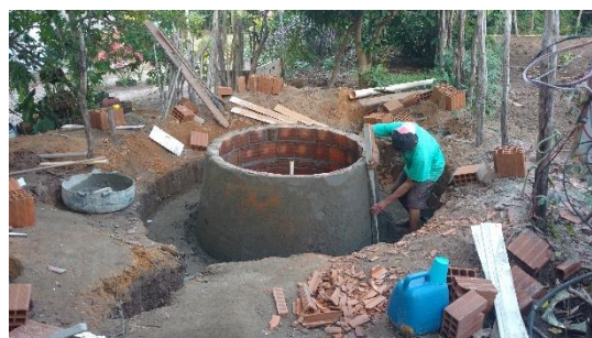
Figura 3 – Mosaico de imagens da estrutura do biodigestor sendo montada. Fonte: (próprio autor)
