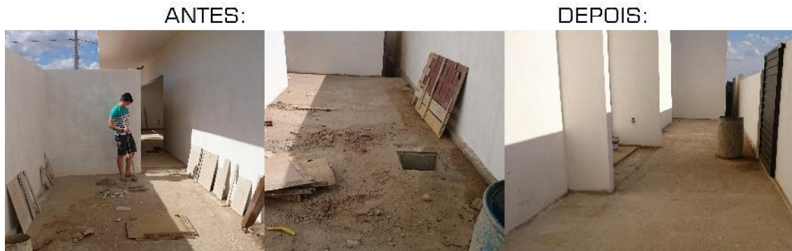
Figura 4 – Entrada principal de pessoas e materiais no canteiro antes e depois da aplicação da ferramenta 5S. Fonte: Medeiros Júnior et al. , 2016
