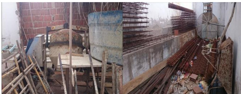
Figura 2 – Armazenamento inadequado de materiais na primeira visita à Obra Hospitalar. Fonte: próprio autor
