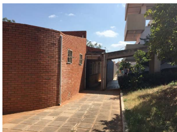
Figura 13 – Captação das águas pluviais em telhados com lançamentos dos volumes em áreas de circulação externa
