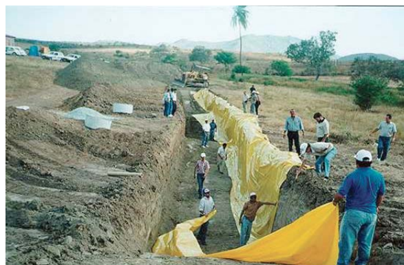
Figura 5 – Construção de barragem subterrânea
