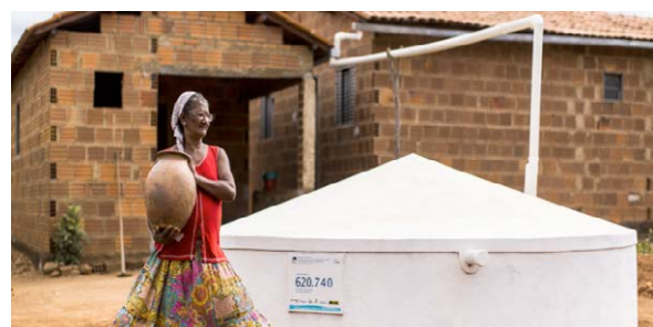
Figura 3 – Cisternas de placa e sistema de captação do telhado do P1MC
