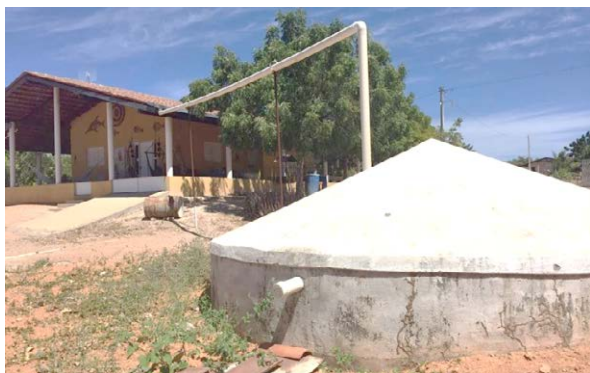
Figura 4 – Cisternas de placa e sistema de captação do telhado instaladas pelo morador da residência em Cajazeiras, PB
